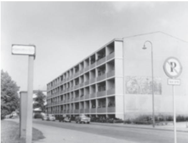
Allbetonghuset i kvarteret Bornholm. Ritat av Fritz Jaenecke & Sten Samuelson 1952. (Foto: Emy Norberg aug 1957, Malmö Stadsbyggnadskontor)
