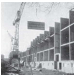
Allbetonghuset under uppförande.
