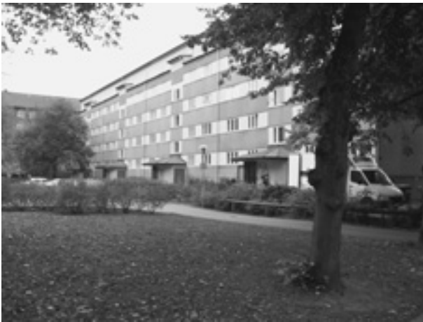
Kvarteret Bornholm 10, Allbetonghuset, gårdssidan. Ritat av Fritz Jaenecke & Sten Samuelson 1952. (Foto: Malmö Kulturmiljö 011021)
